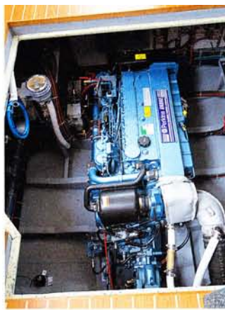
Im Maschinenraum ist reichlich Platz für die Inspektionen
